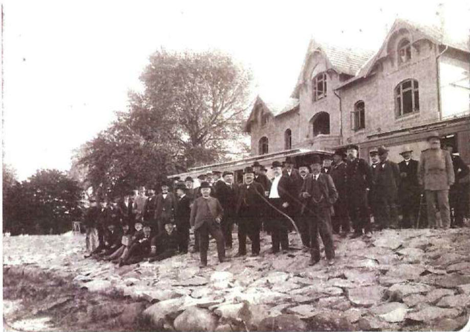
Personale, bygherre og andre har taget opstilling ved Årø Sund Station - sidste hold på Haderslev-Årø Sund linjen. Det næsten færdige Årø Sund Badehotel ses i baggrunden.
